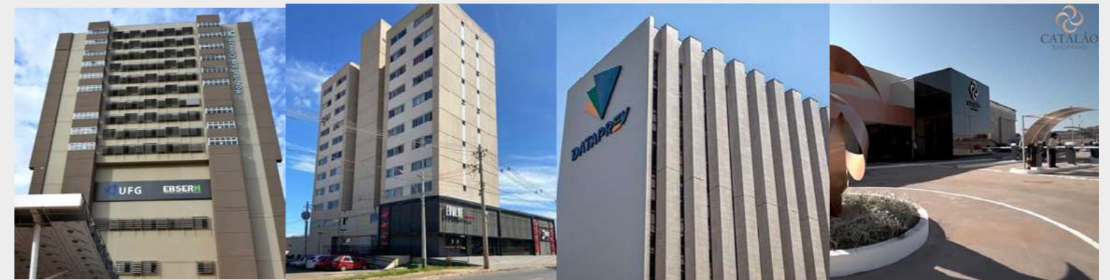
Construção do Hospital das Clínicas da Universidade Federal de Goiás
